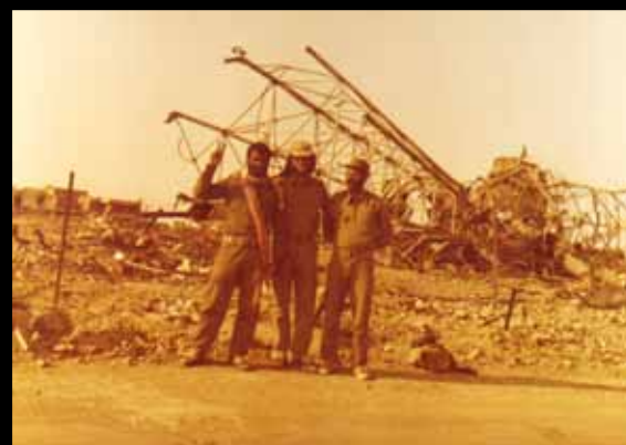
کنار منبع آب شمال شهر خرمشهر
