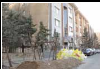
چاهی که برای زهکشی کوچه سوم خیابان پیروزان حفاری شده است.
